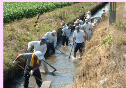
水路の泥上げ
