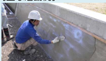
老朽化した水路壁のコーティング
