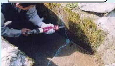
水路のひび割れ補修
