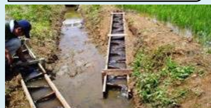
水田魚道の設置
