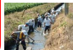
水路の泥上げ
