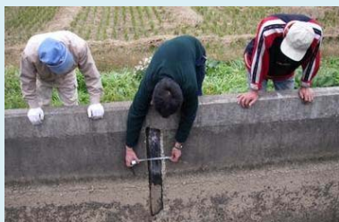
施設の機能診断
