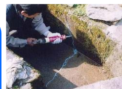
水路のひび割れ補修
