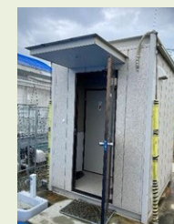
県下9箇所のほ場に清潔なトイレを設置
